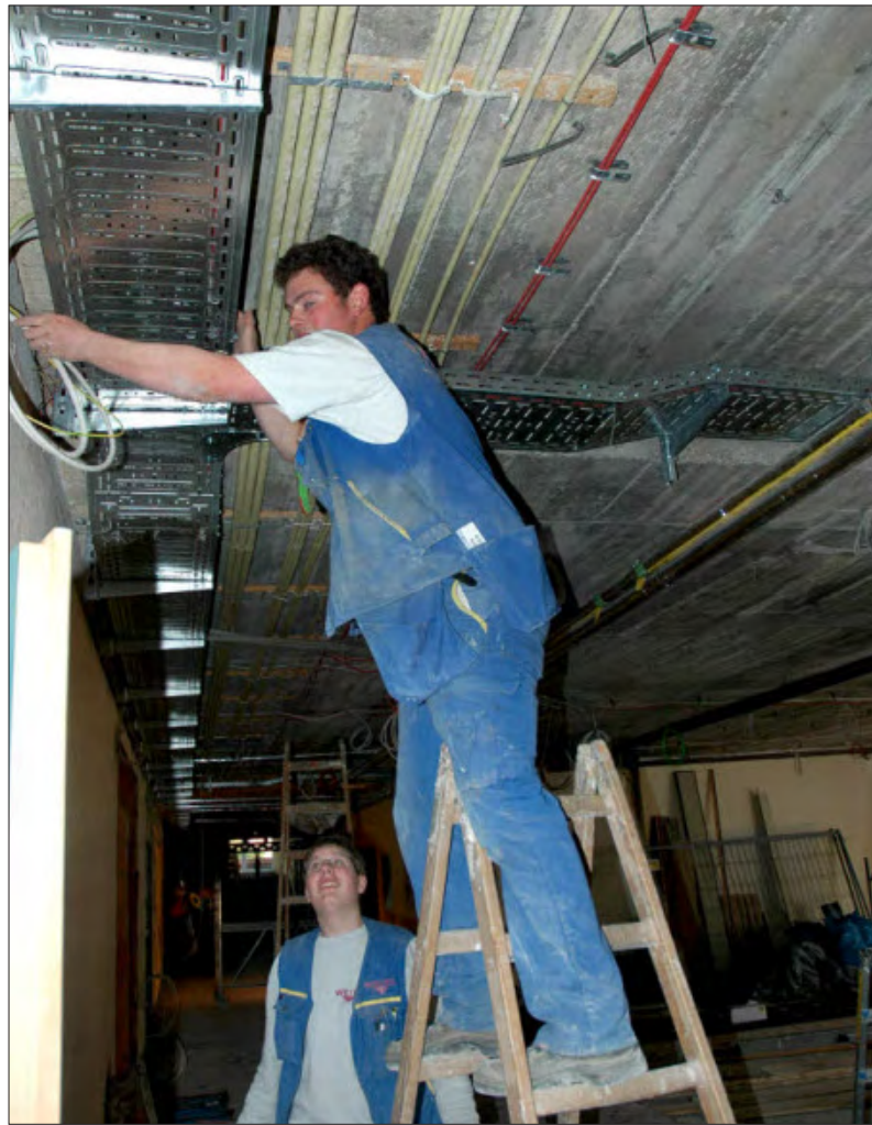
Die Männer der Bodenmaier Firma Weigl verlegen derzeit im 1968 erbauten Schultrakt neue Elektroleitungen. Die Flure in diesem Bauteil werden jetzt Schritt für Schritt saniert. (Fotos: Schlenz)
